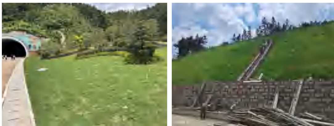
图 5-1 道路沿线绿化工程照片
