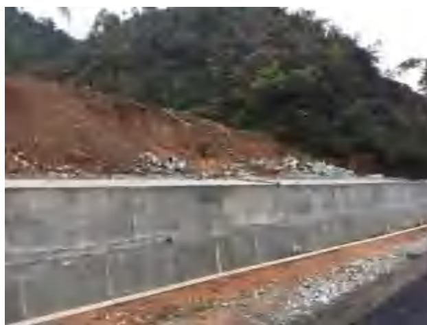
图 9-1 施工期竹垌连接线处弃土场
